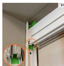
Ajuste la longitud del cable de carga interno negro usando la fórmula: Agujero H - 17 cm
